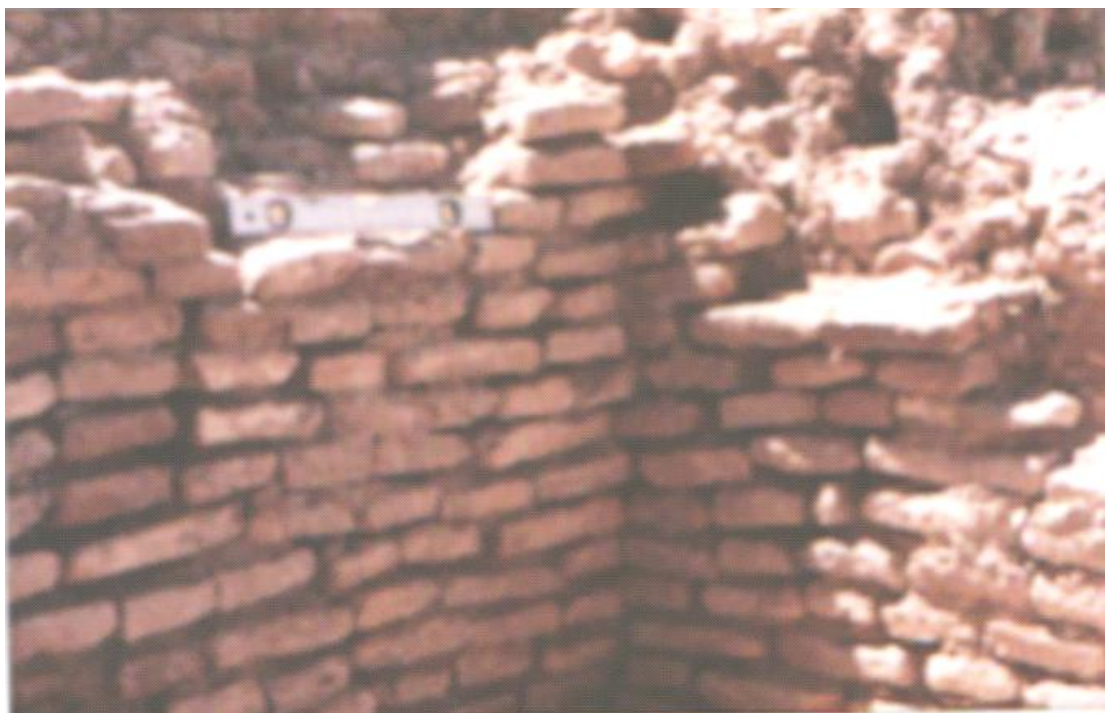
Рис.11. Для раннесредневекового периода характерны сырцовые кирпичи прямоугольной формы с соотношением 1:2
